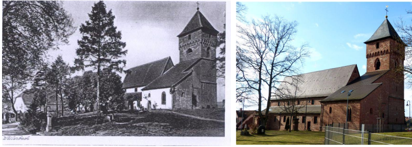
Abb. 31: Erweiterung der kath. Kirche 1930
